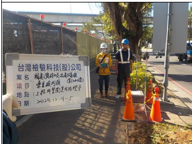
監測項目：環境噪音振動 監測日期：2024.12.04~05 監測地點：工務所警衛室外路燈旁
